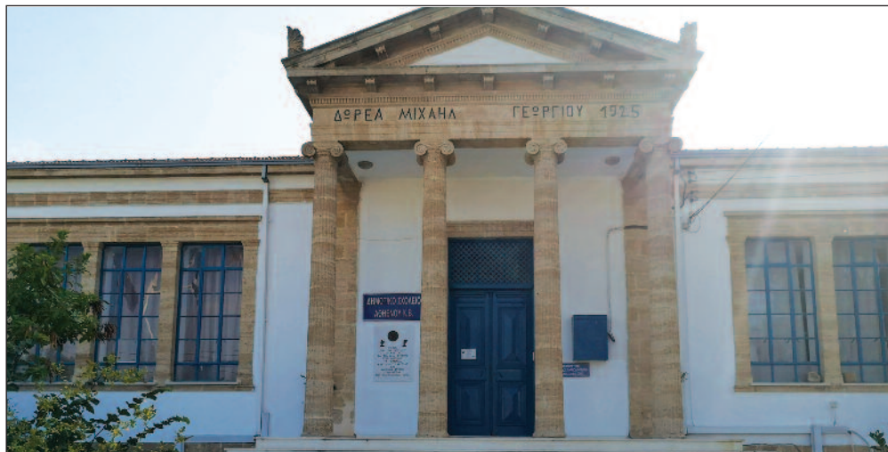
Δημιουργία Γαλακτοκομικής Σχολής τριτοβάθμιας εκπαίδευσης, στον χώρο του διατηρητέου κυρίου του παλιού Δημοτικού Σχολείου Αθηνών (πρώην Γυμνάσιο)
