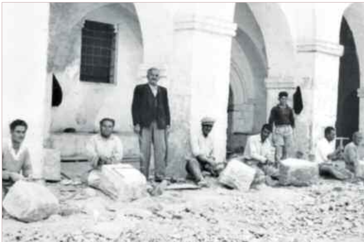
Αθηναίνοι και Καϊμακλιώτες πετροπελεκητές μπροστά στον ηλιακό της παλιάς εκκλησίας της Παναγίας πελεκούν πουρόπετρες του Όρους για το κτίσιμο της νέας εκκλησίας της Παναγίας. Φαίνονται οι καμάρες του ηλιακού, ο οποίος κατεδαφίστηκε αργότερα, για να διευρυνθεί η απόσταση μεταξύ της παλιάς και της νέας εκκλησίας. Όρθιος, με μαύρο σακάκι, διακρίνεται ο Καϊμακλιώτης μάστορας Νικόλας Α. Σιαμαρίας, που ξεκίνησε το κτίσιμο της εκκλησίας, αλλά δεν το ολοκλήρωσε. Ο μικρός στην φωτογραφία είναι ο Κώστας Γαβριλάς (Μαριονής). Στο άκρο αριστερά είναι ο Πέτρος Τύμβιος και στο άκρο δεξιά ο Μιχάλης Γαβριλάς, πατέρας του Κώστα
