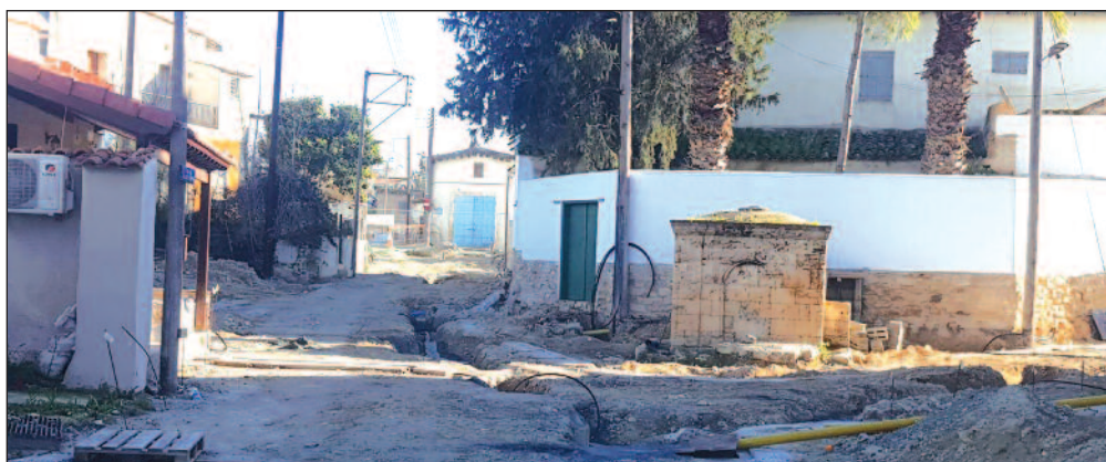
Κατασκευή της Πλατείας της Βρύσης
