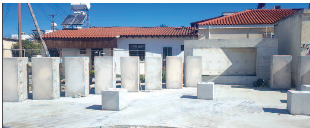
Κατασκευή του Μνημείου Πεσόντων και Αγνοουμένων
